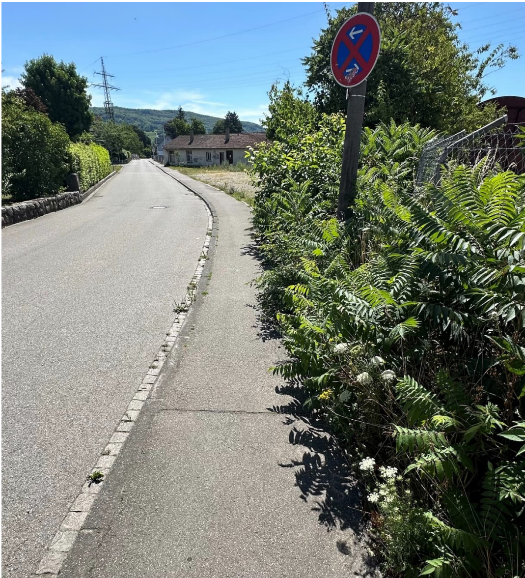
Abbildung 9: Eimeldinger Weg - Bewuchs auf Gehweg (Quelle: FWT)
