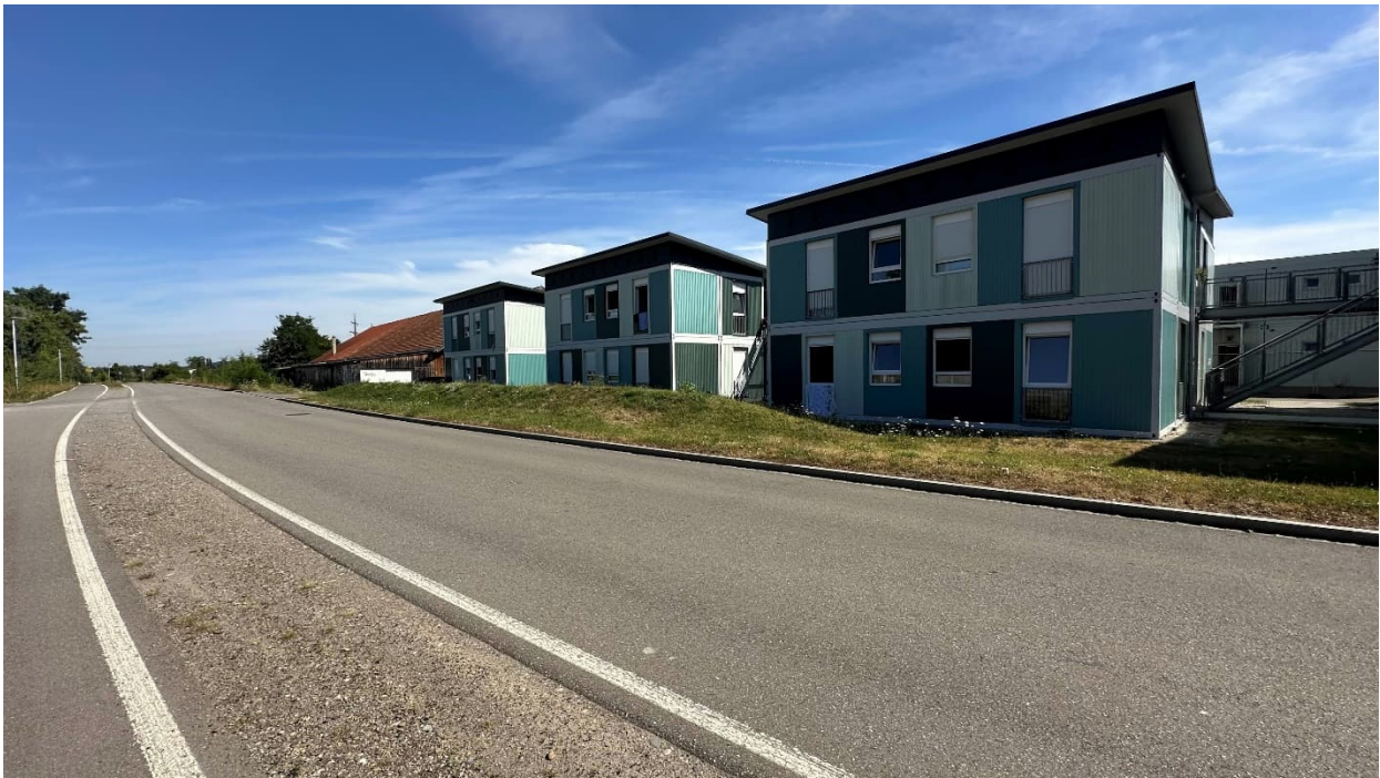
Abbildung 2: Plangebiet Bestand - Flüchtlingsunterkünfte (Quelle: FWT)
