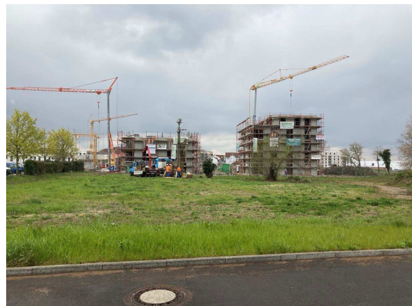
Abb. 2: Blickrichtung Süd von Heizzentrale
