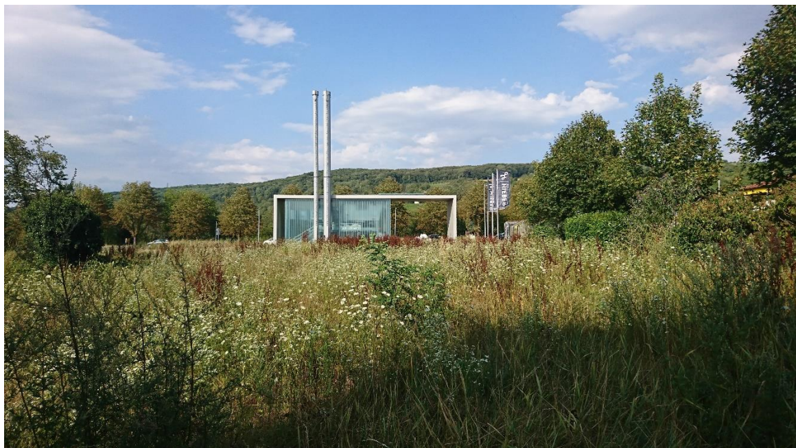
Abbildung 6 Blick von Südwesten auf die Vorhabensfläche und das Blockheizkraftwerk.
