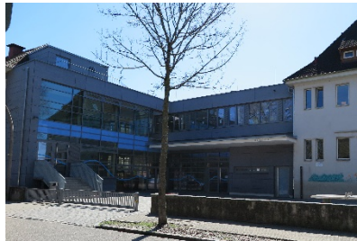
Zugang zum Schulgelände von der Karsthölzlestraße
