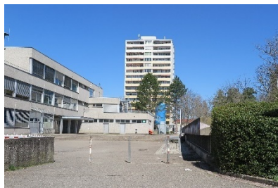
Zugang auf den Schulhof
