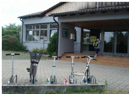
Haupteingang der Schule mit Abstellanlagen im Vordergrund
