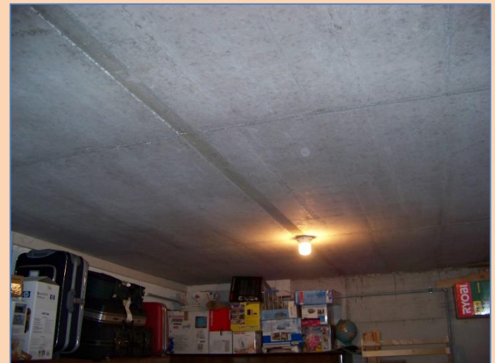
Ungedämmte Kellerdecke
